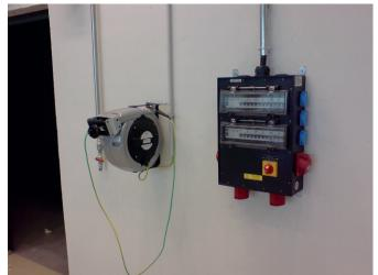
Steckdosenverteiler Hartgummi Typ 7800 (Wandmodell):
